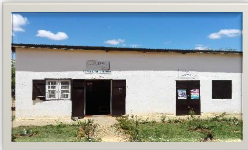
Figure N°8 : Bureau gestionnaire système d'adduction d'eau d'Ambohimalaza Miray
